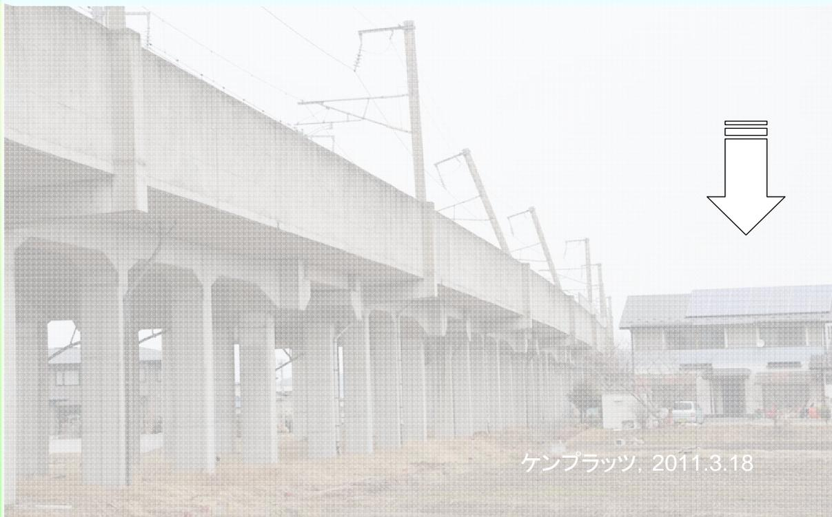
第3岡島高架橋は耐震補強されて以内が、躯体に損傷がなかった(写真:高橋良和・京都大学防災研究所准教授) 原典:ケンプラッツ, 2011.3.18
