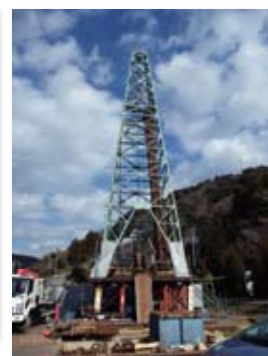
南伊豆地域で実施した坑井掘削
