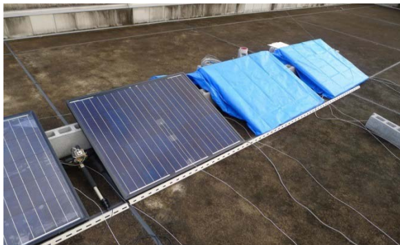
図 11：右から、ブルーシート 2 枚、ブルーシート 1 枚、普通モジュール
