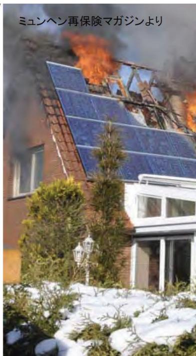
第一故障(非接地IT系直流一線地絡時)には、放水による帰路形成が命取り。消防士の感電防止のためには「見守る」しかない。(消防士のための保険は、放水を認めていない)
