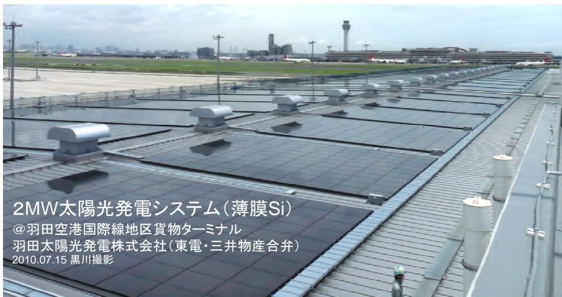
図 10 折板葺きの工場建屋の太陽光発電アレイの典型的な施工方法
