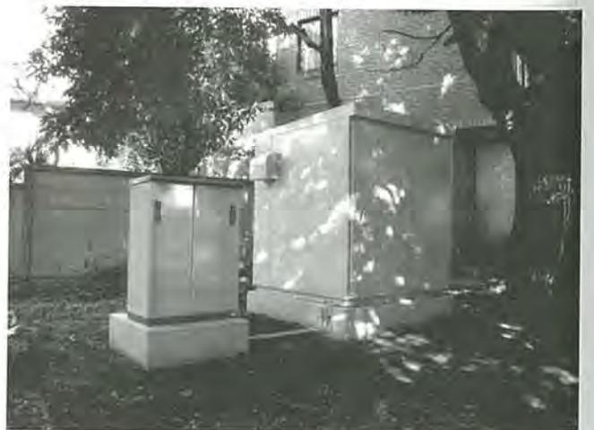
図6 パワーコンディショナと計測機器が設置されたキュービクル(右)と8.96 kWhの鉛蓄電池(左)
