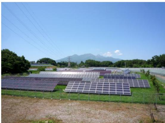
図 1 に設置された約 30 種の太陽電池を用いた 2MW メガソーラ（山梨県北杜市）
