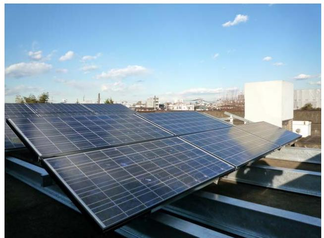
図5 東工大大岡山キャンパスに設置された2.59 kW 実証試験用太陽光発電システム
