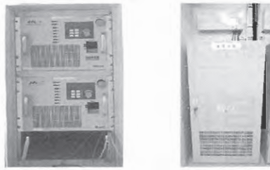
図4 パワールーター(左)とパワコン・蓄電池(右)
