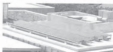
図3 太陽光発電パネル
