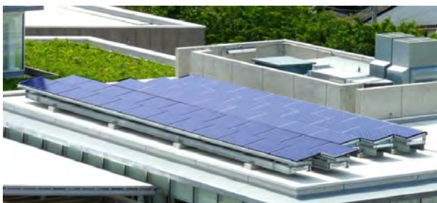
図3 TTF 屋上に設置された 10kW の PV システム
