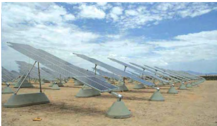
図10 14 MW ネリス（ネバダ州）の追尾架台（SunPower 社）
