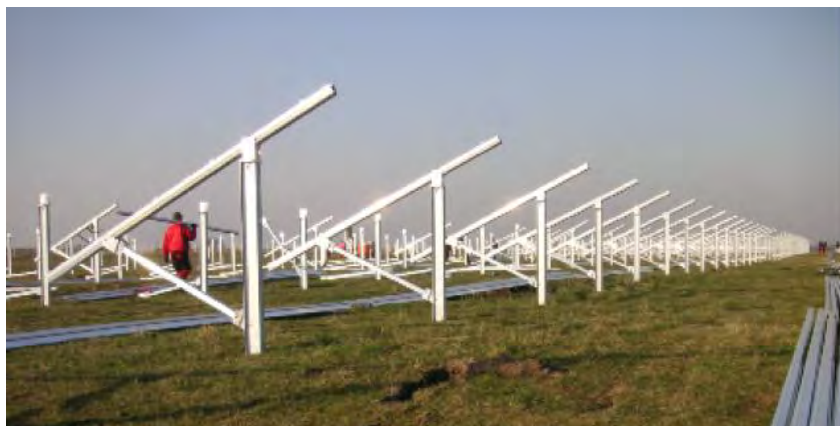
図9 ブランディス・プラントの軽量架台構造
