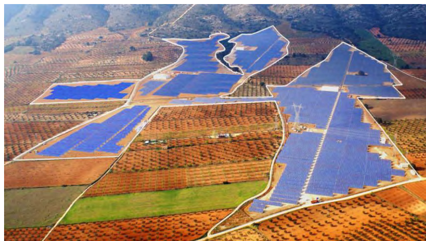
図7 20 MW ベネセマ・プラント
