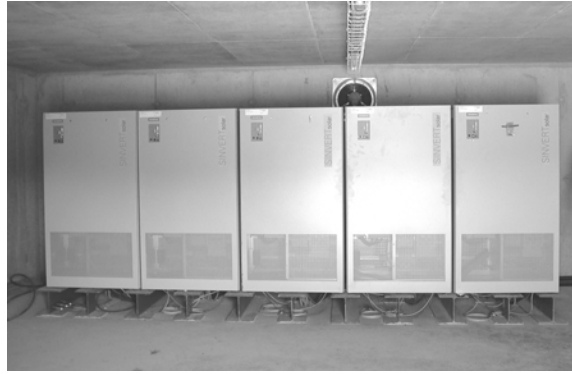
図 1 1 ヘマウの 80kVA インバータ群の一部 (14)
