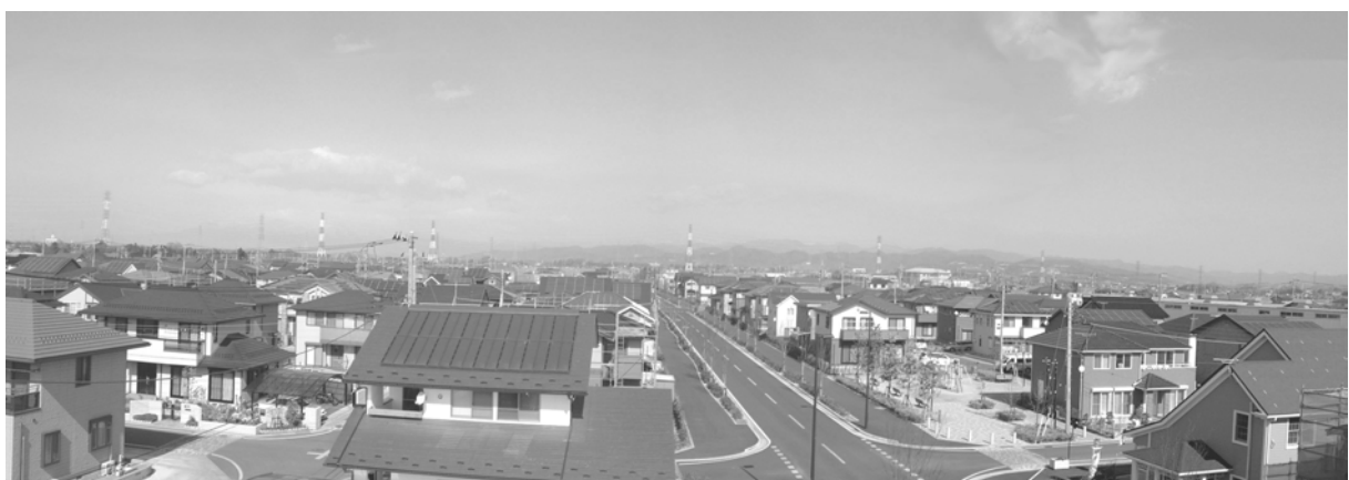
図 6 NEDO 集中連系・城西の杜の建設状況（平成 15 年度末までに 150 戸 PV 化の予定）
